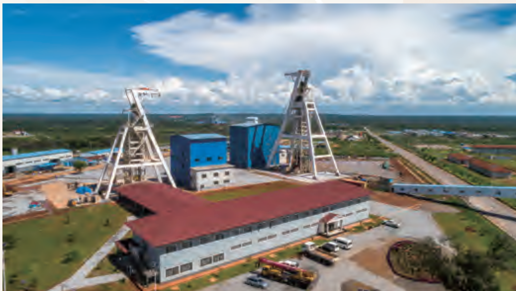
中色非礦東南礦體主、副井
