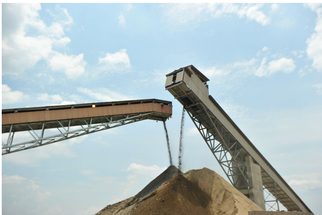
谦比希铜矿主矿体与西矿体卸矿作业
