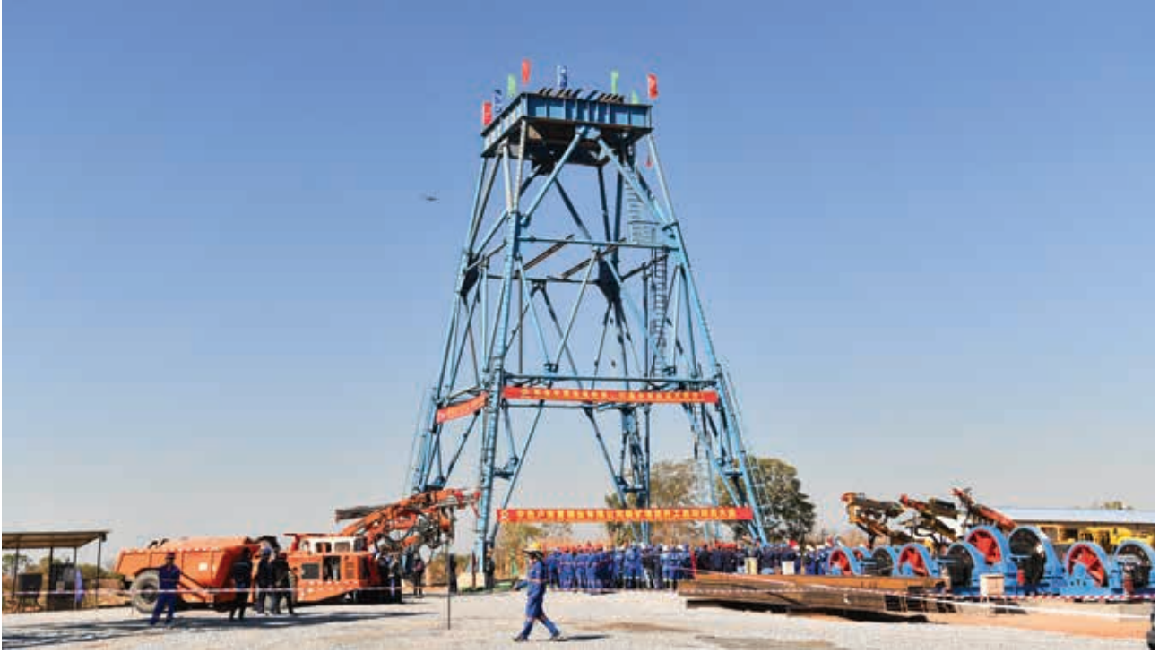
中色盧安夏新礦項目開工啟動大會現場
