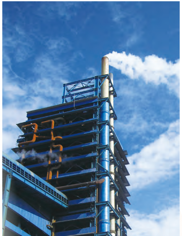
銅冶煉公司ISA爐廠房
