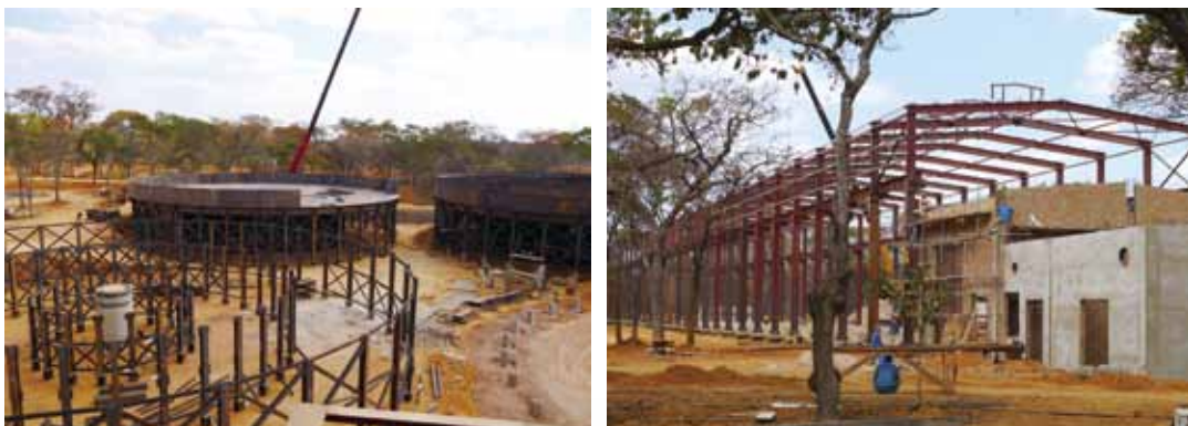
Mabende濕法銅項目建設現場
