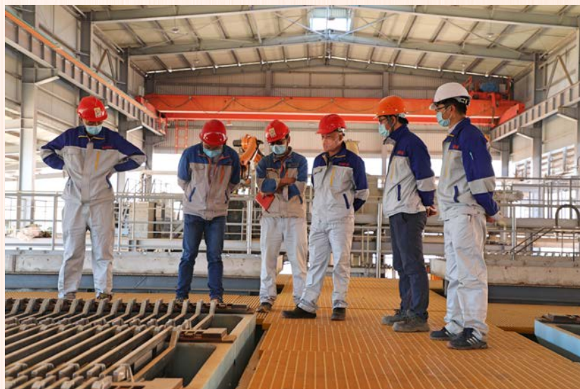
剛波夫礦業萃取電積車間
