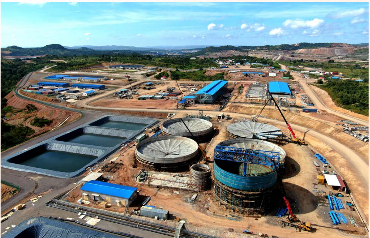
剛波夫礦業濕法廠施工現場
